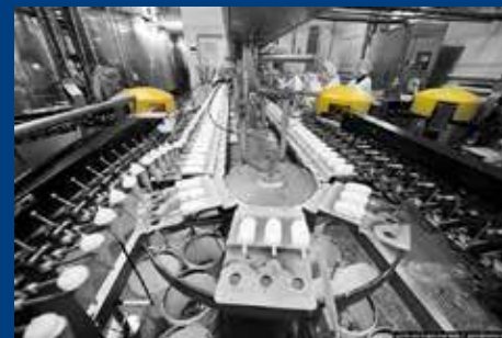
Installation de Transformation des Produits Congelés
